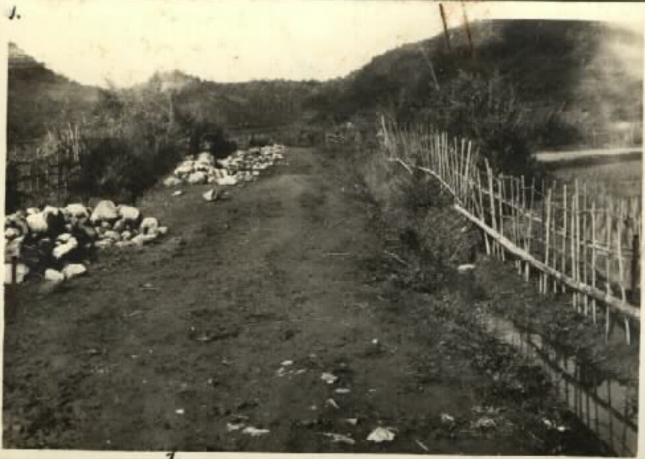
Rehab Djalan Gelelungi.
