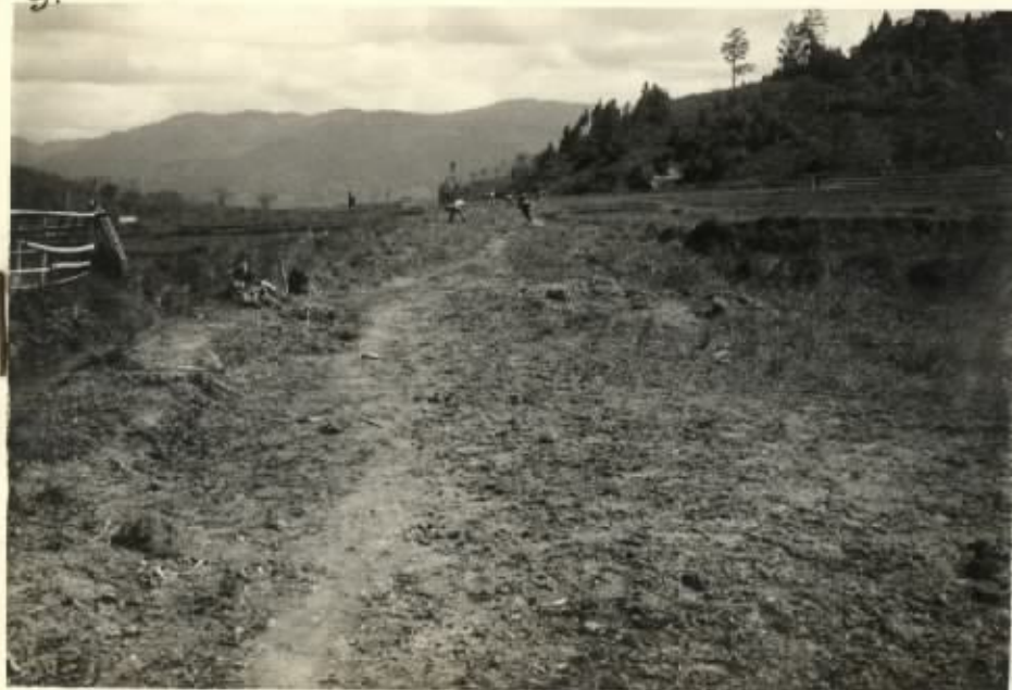
Rehat jalan Berawang Gading.
