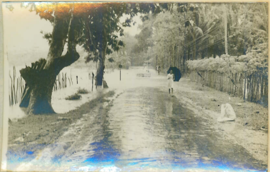
Djl. Jos Sudarso ( djalan Propinsi ) djurusan Lapangan Terbang Km. 2 + 950 M sepanjang \pm 75 M terendam air sedalam 0,75 M.
