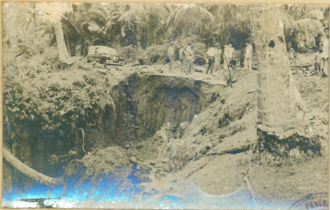
Djl. Djurusan Balohan ( Tk.II ) Km. 9 + 300 M, berm djalan longsor digagas air sepanjang ± 15 M dalam 3 M dan lebar 4 M.
