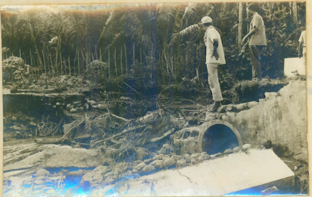
Djl. Djurusan Anoi Itam ( Km. 10 ) urung2 beton \phi 0,80 M dubbel putus sebelah dihanjutkan air ke Laut.
