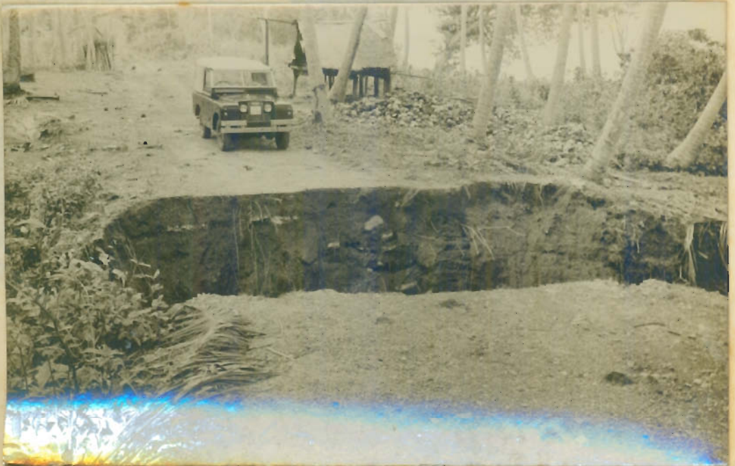
Djl. Djurusan Anoi Itam ( Tk.II ) Km. 9 djembatan plat beton (bekas Djepang) runtuh dibawa air alur.
