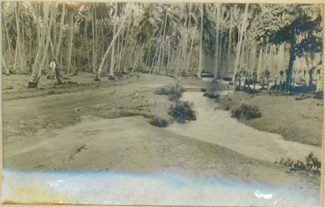
Djl. Djurusan Balohan ( Km. 10 + 250 M ) air dari alur akibat hudjen melimpah ke djalan dan berm digegas air sepanjang \pm 20 M, dalam 2 M dan lebar 2 M.
