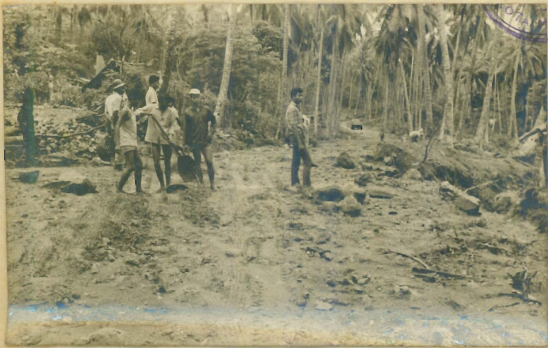
Djl. serupa diatas tertimbun batu2 / pasir longsor dari bukit sebelah kiri djalan ke Balohan.
