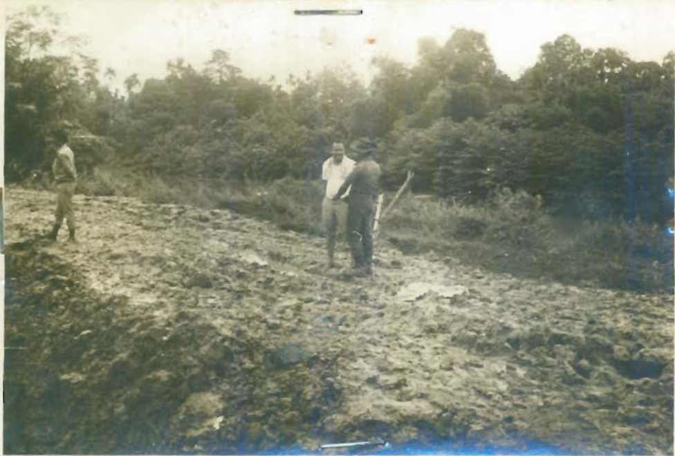
Pekerdjaan Dam Penutup siap dikerdjakan 100%.
