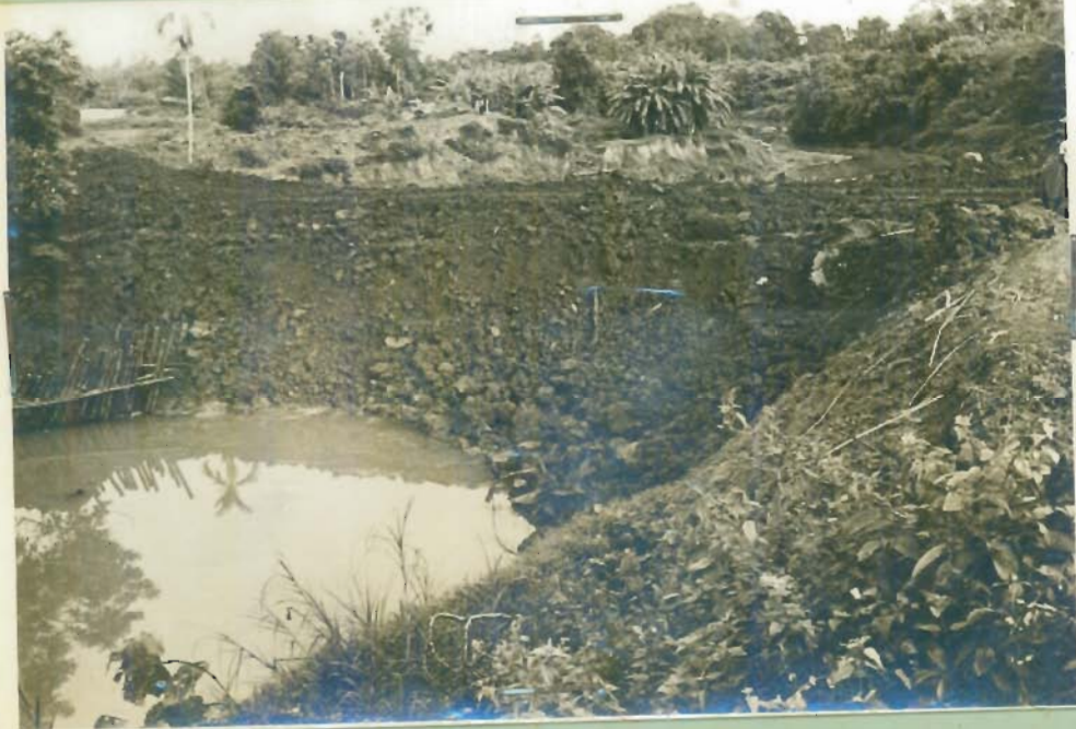
Pekerdjaan Dam Penutup sedang dikerdjakan.
