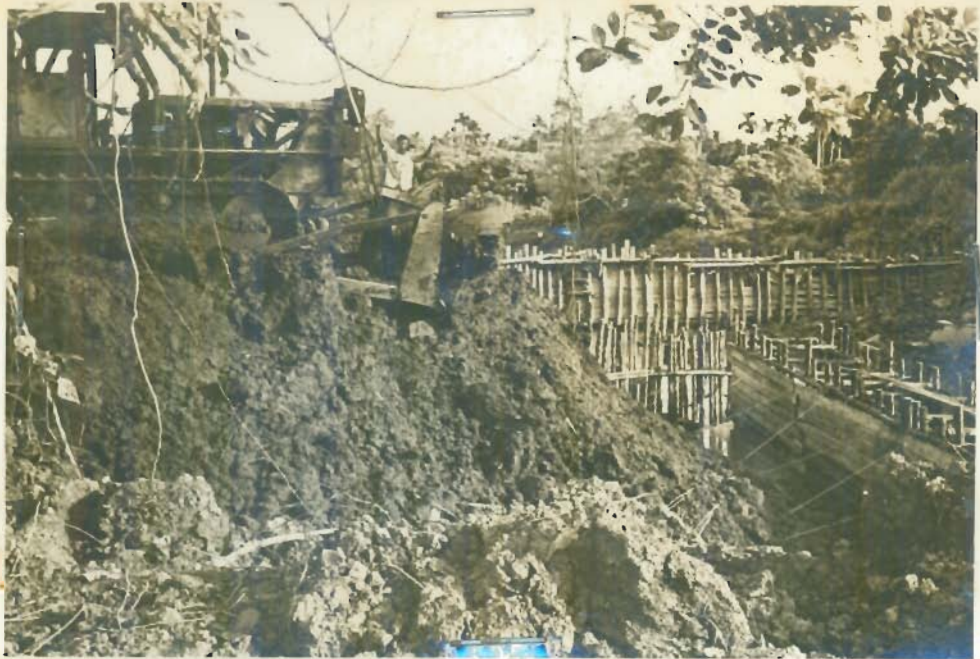
Pekerdjaan Dam Penutup sedang dikerdjakan.
