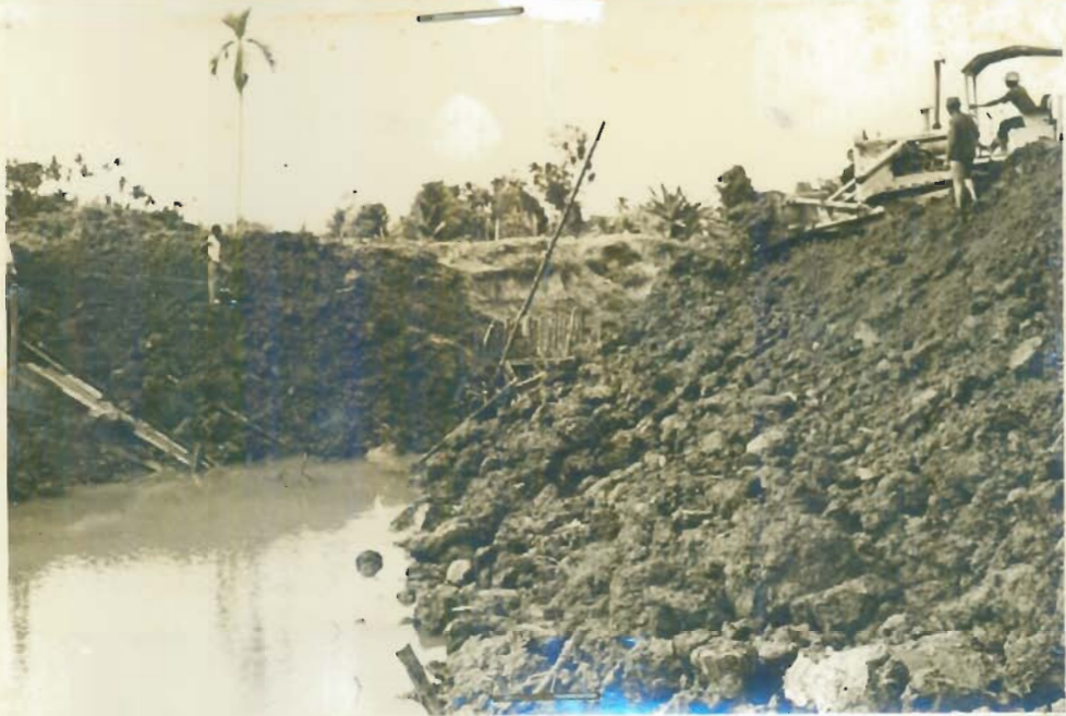
Pekerdjaan Dam Penutup sedang dikerdjakan.
