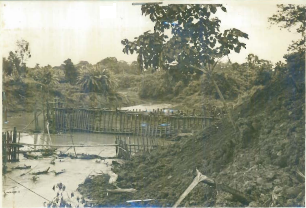
Pekerdjaan Dam Benutup sedang dikerdjakan.
