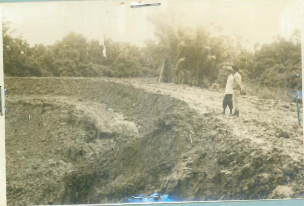
Pekerdjaan Dam Penutup siap dikerdjakan 100%.
