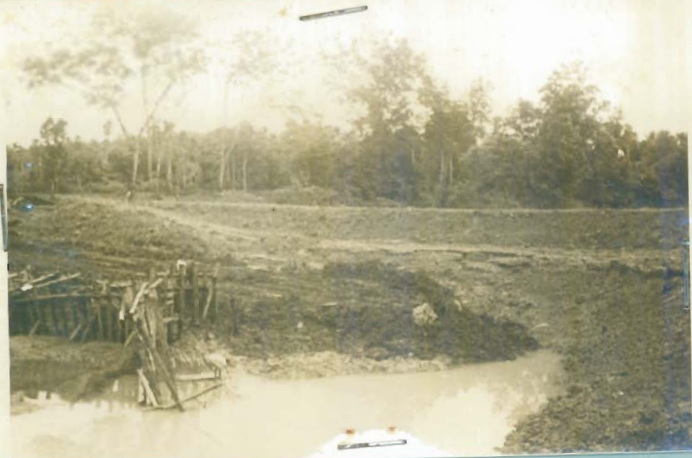
Pekerdjaan Dam Penutup siap dikerdjakan 100%.
