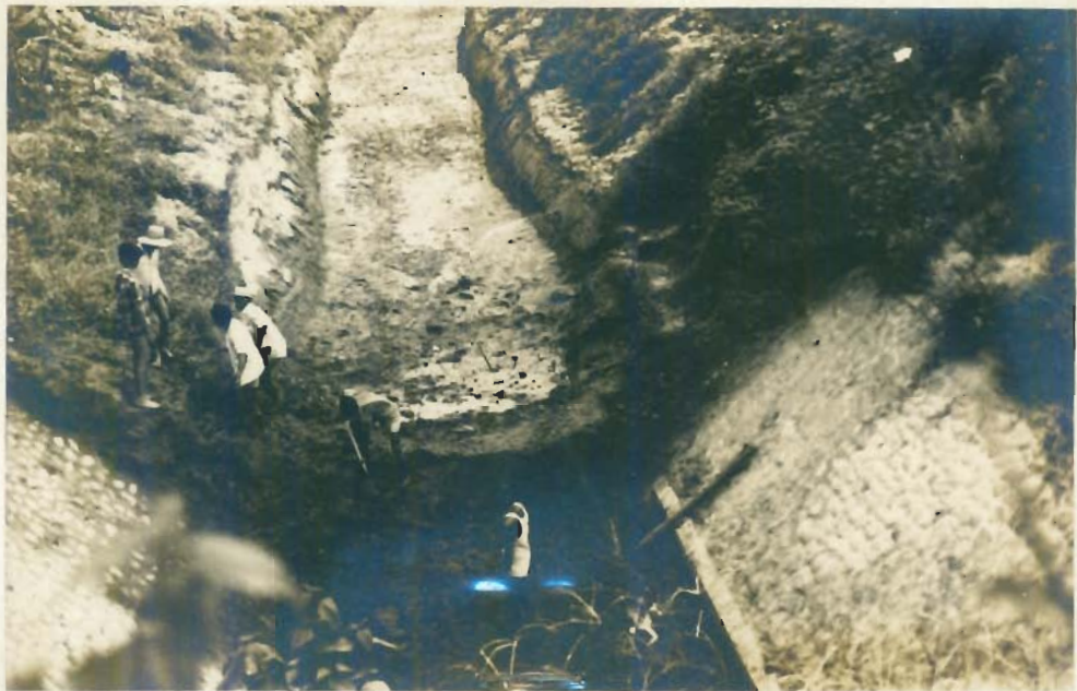
SALURAN BAGIAN PINTU PEMASUKAN SEDANG DIKERDJAKAN
