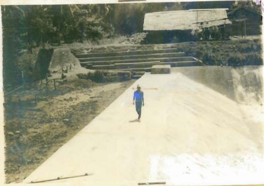
STUW DAM PENGAIRAN TJOT GELUMPANG DI BULOH BLANG ARA SETELAH SIAP DIKERDJAKAN OLEH PEMBORONG, DI- LIHAT DARI ATAS TANGGUL.-
